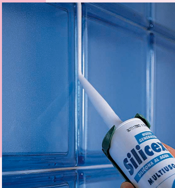
1. Aplicar la Silicona Rhodalis en la junta.
