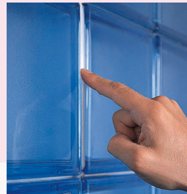
3. Pasar el dedo índice para que la silicona entre bien en la junta.
